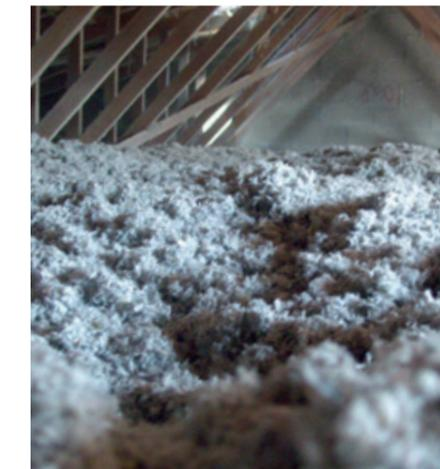
Quate de cellulose - isolant performant issu du recyclage du papier
